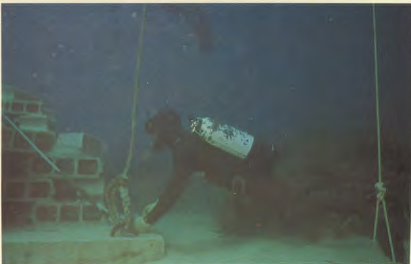
Plongeur libérant les câbles d'amarrage d'un récif sur le fond
