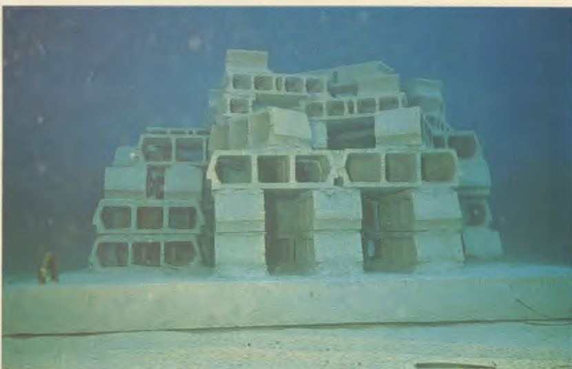
Récif construit sur dalle béton, poids unitaire : 7 tonnes
