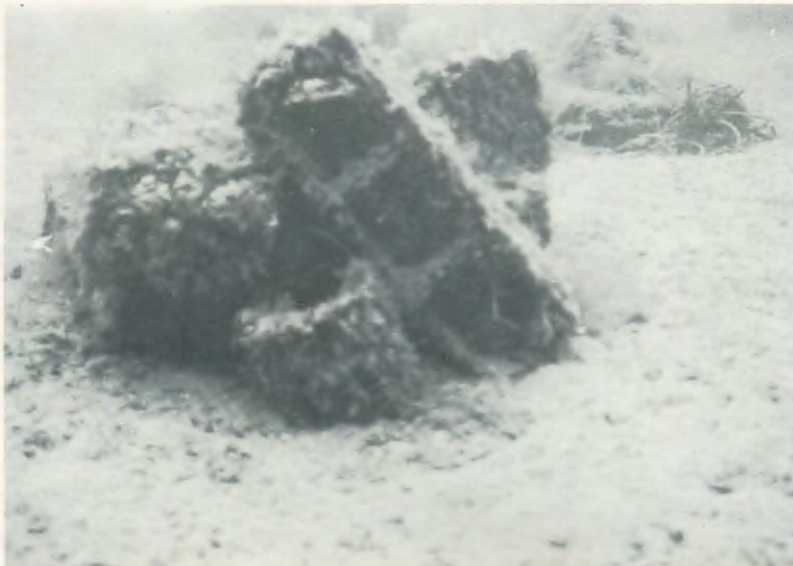
Réserve sous-marine de Monaco Récif alvéolaire construit à la main sur les fonds.
