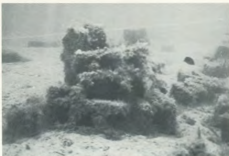
Réserve sous-marine de Monaco Récif alvéolaire construit à la main sur les fonds.
