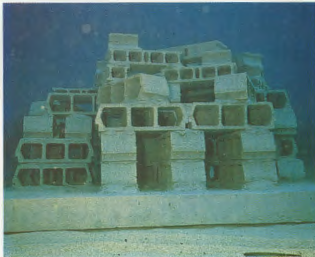
Récif construit sur dalle béton, poids unitaire : 7 tonnes
