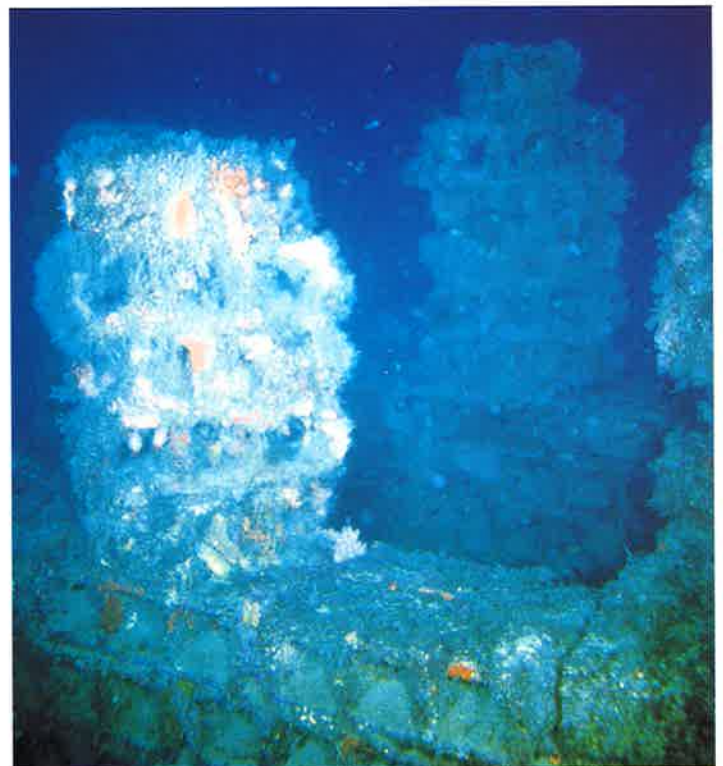
Photo 1 Les piles d'hourdis enlevables sur le récif à 30 m de profondeur.
